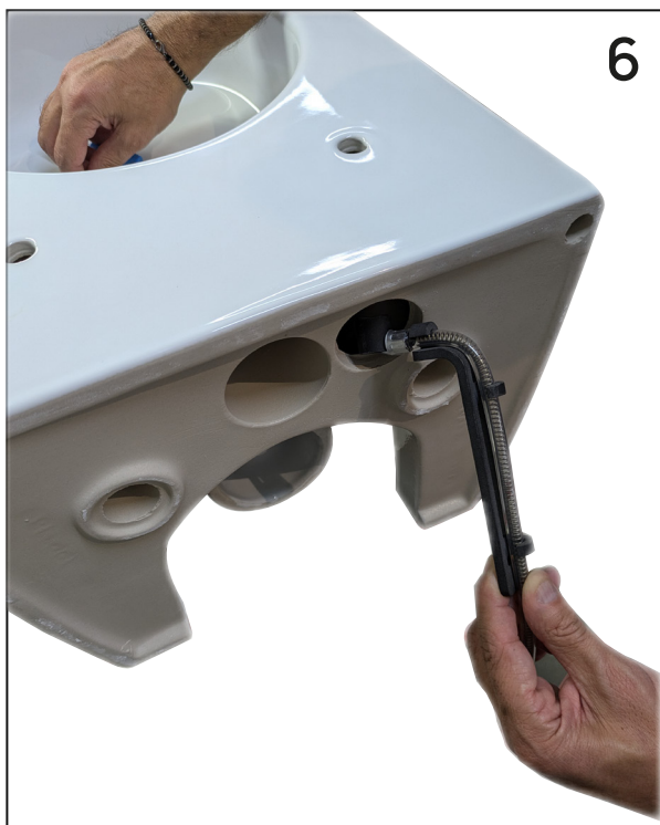
inserire l'erogatore nel canale ceramico insert the dispenser into the ceramic canal
