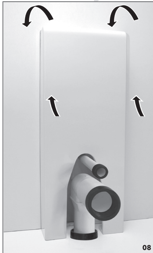
08 Installation du réservoir Niagara: accrocher le de haut en bas.
