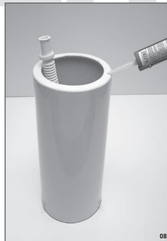
08 Predisposizione al fissaggio del lavabo alla colonna: stendere un cordone di silicone sul bordo superiore della colonna. Preparation for the basin fixing: cover the entire border of the column with silicone.
