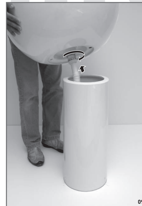
09 Collegamento del lavabo al sifone: avvitare il tubo di scarico flessibile alla piletta del lavabo. Connection of the siphon to the basin: tighten the flexible pipe to the drain.
