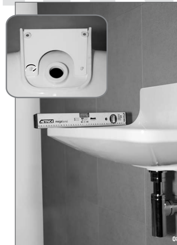
08 Fissaggio del lavabo e messa in bolla: fissare il lavabo alla staffa, intervenire sui grani in plastica per il livellamento. Fix and level the washbasin: fix the washbasin to the bracket and check its level turning the plastic screws.
